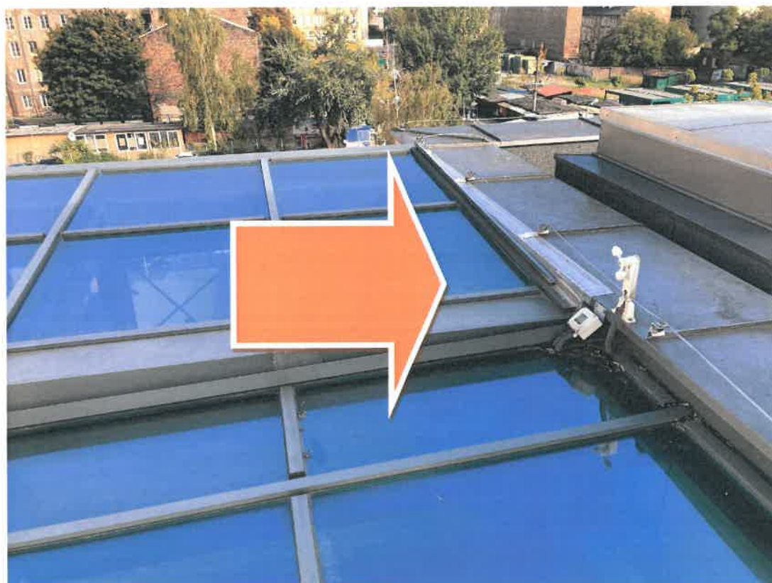
Fot. 44. Widok uszkodzonych obróbek – łatanie, lepienie, prowizorka; są to miejsca przecieków wody opadowej - przedłużenie w osi E
