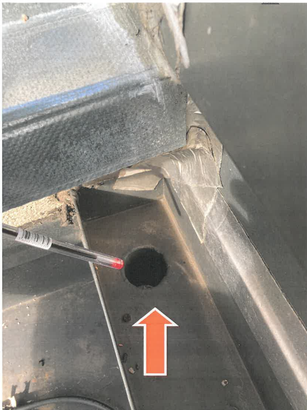
Fot. 20. Widok rury spustowej rynny odprowadzającej wodę z części frontowej świetlika – średnica 50 mm
