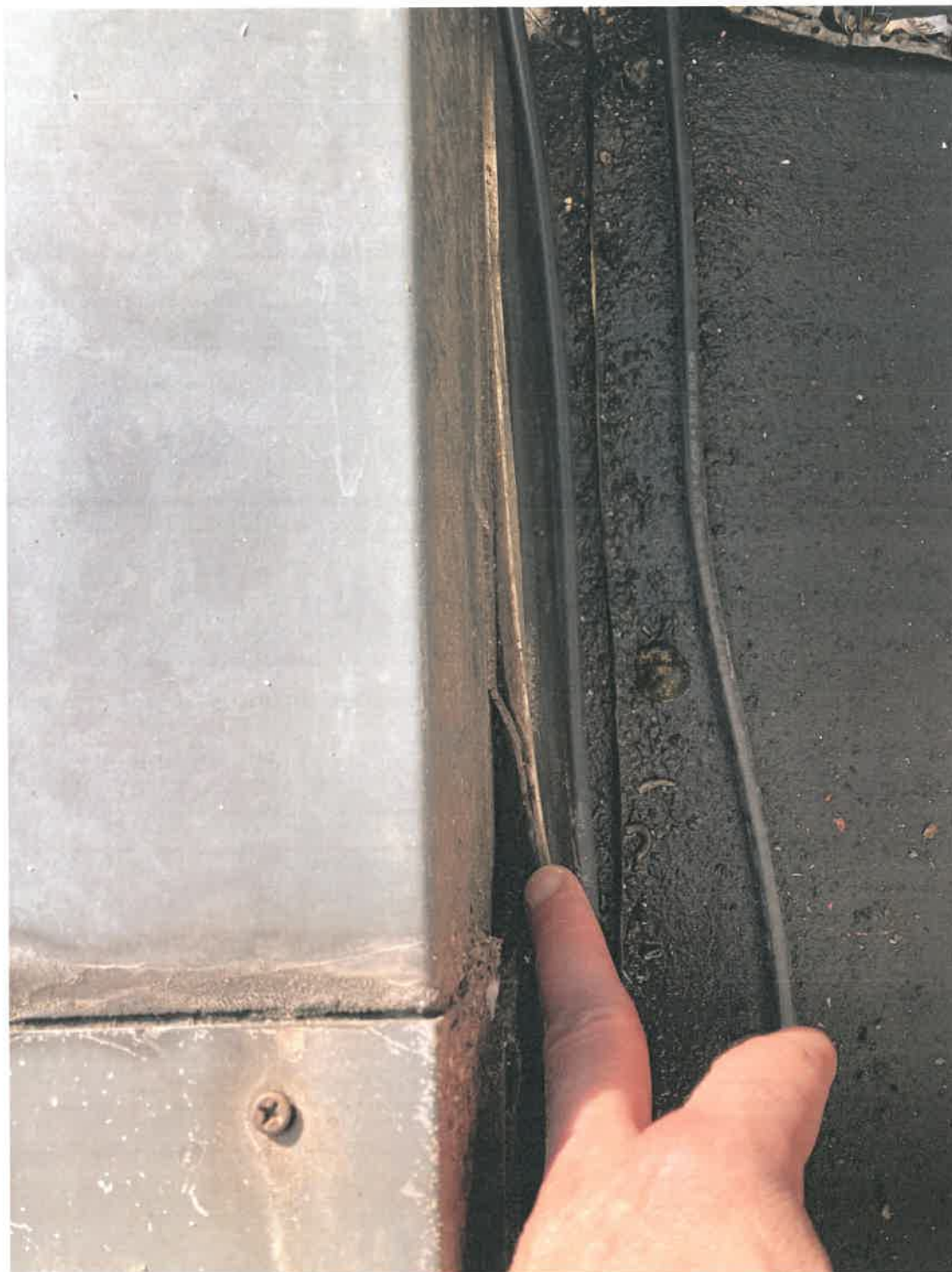
Fot. 41. Widok uszkodzonej obróbki rynny w osi B; miejsce przecieku wody opadowej
