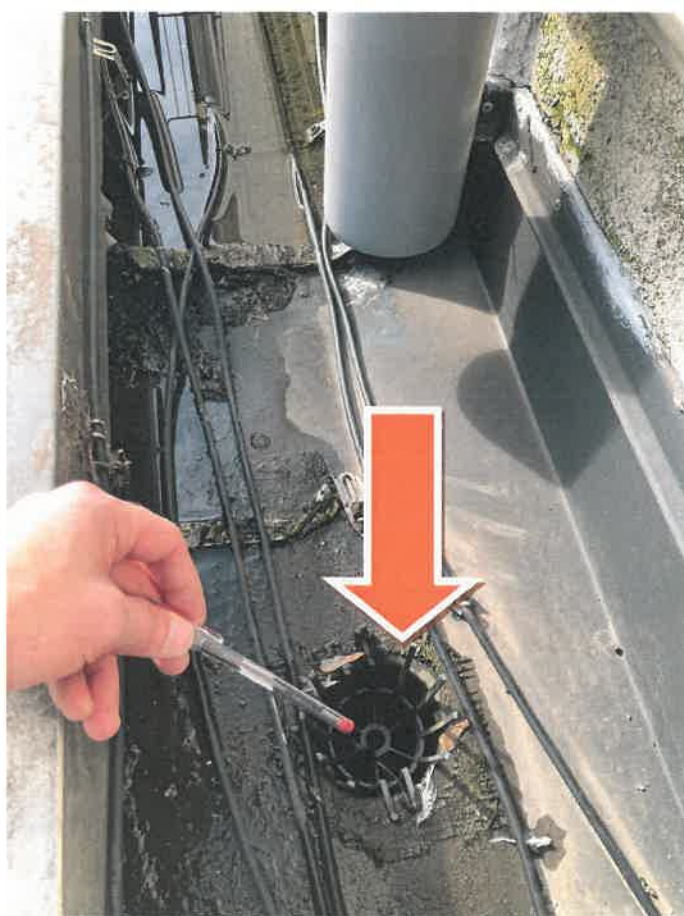
Fot. 18. Widok rury spustowej z kondygnacji +5 oraz drugiego z trzech odpływów rynny w osi B; widoczna zalegająca woda
