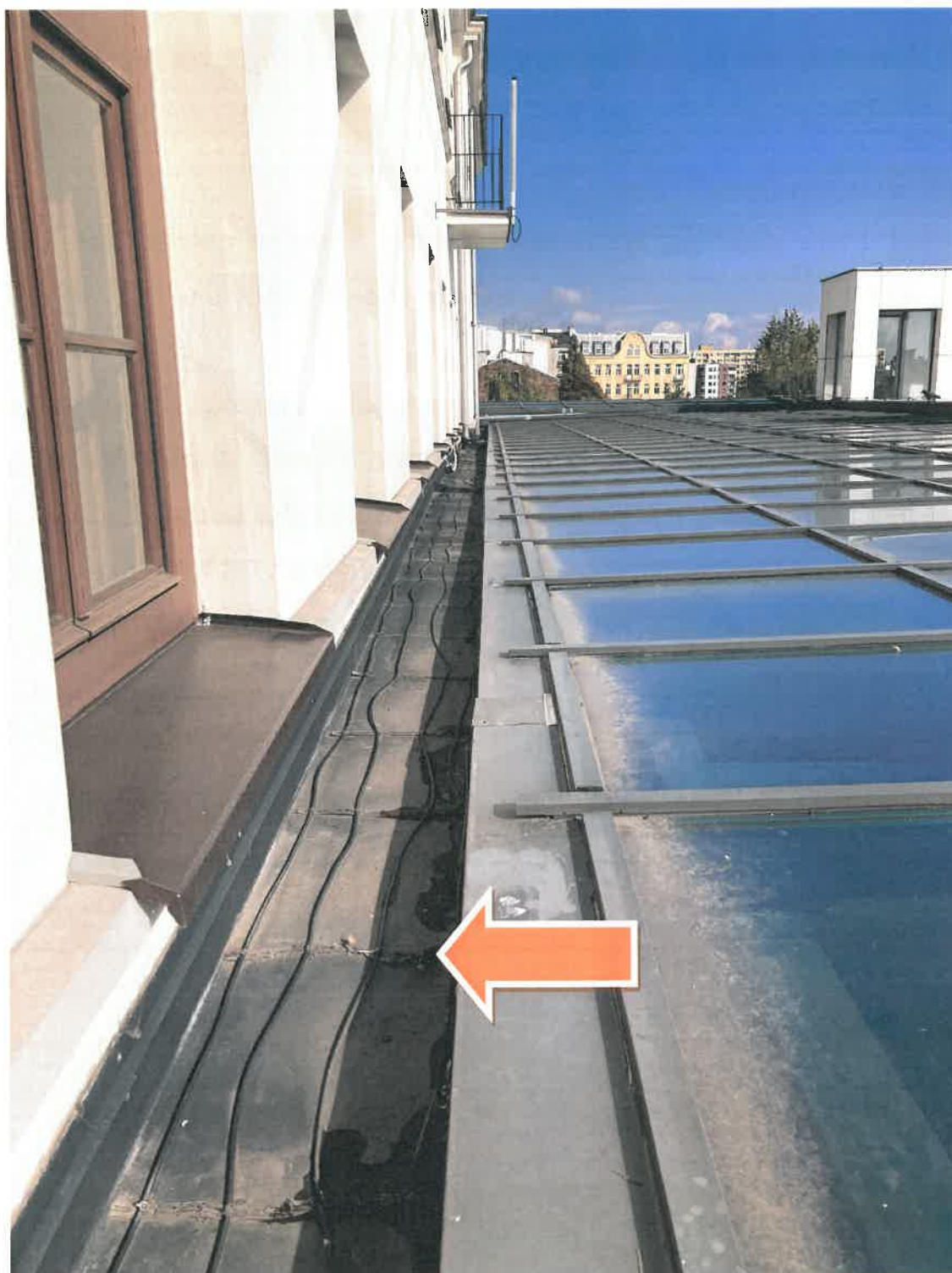
Fot. 13. Widok rynny w osi B wzdłuż najniższej położonej krawędzi świetlika (widoczne również kable grzewcze)
