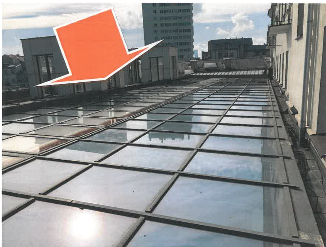
Fot. 30. Kłapy oddymiające – zaleganie wody widoczne na szybach, zaznaczone strzałką
