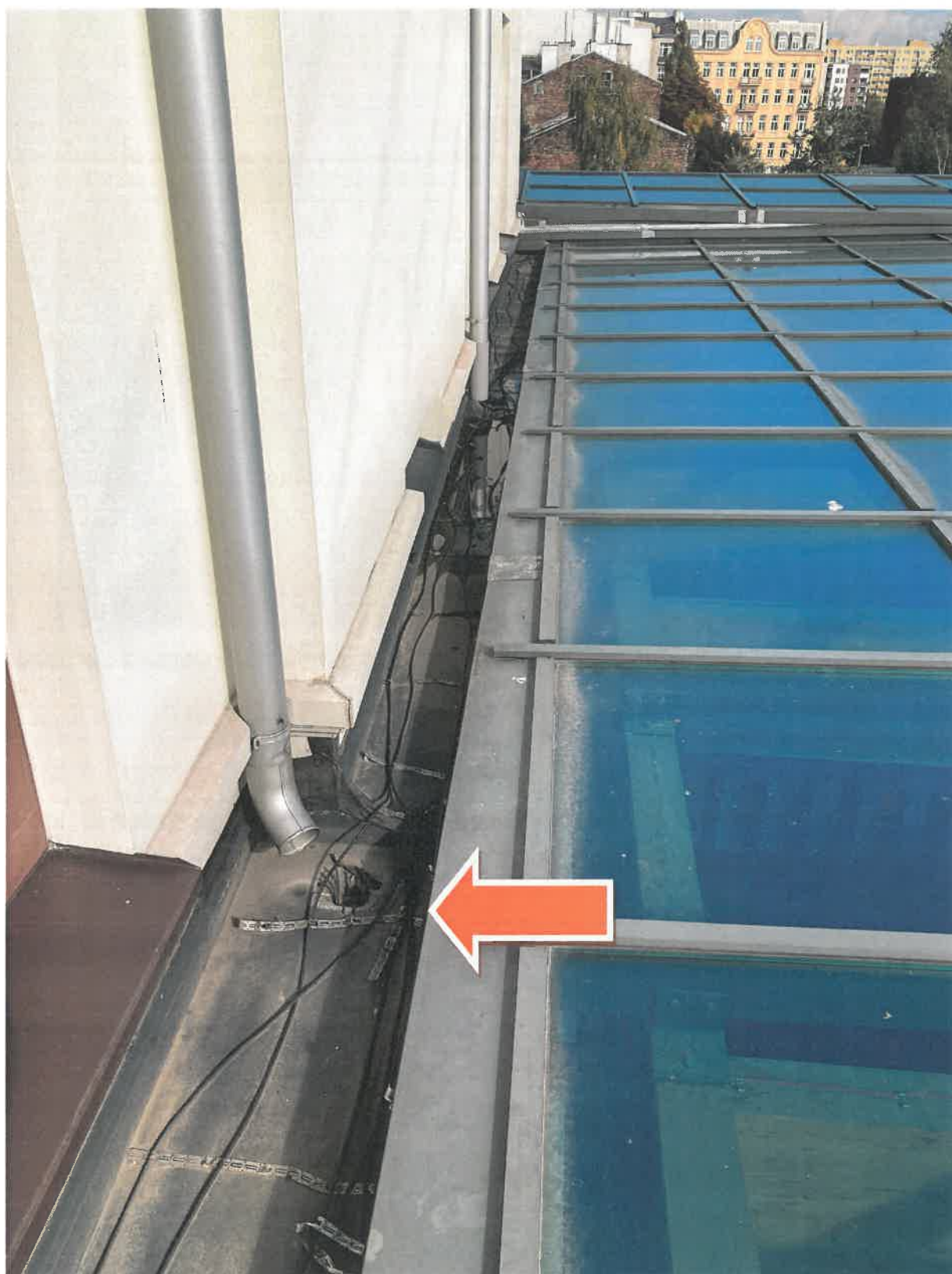
Fot. 14. Zrzut wody z części dachu na poziomie +5/6 do rynny w osi B – widoczny przekrój rury spustowej
