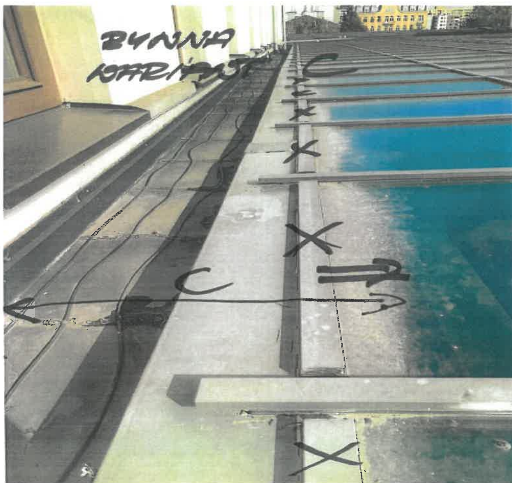
Fot. 23. Widok ilustrujący Wariant C – stan zalecany (strzałkami zaznaczono przesunięcie linii rygli, literą x oznaczono dociski do usunięcia)
