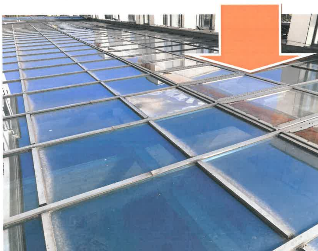
Fot. 32. Klapy odymiające – zaleganie wody widoczne na szybach, zaznaczone strzałką cd
