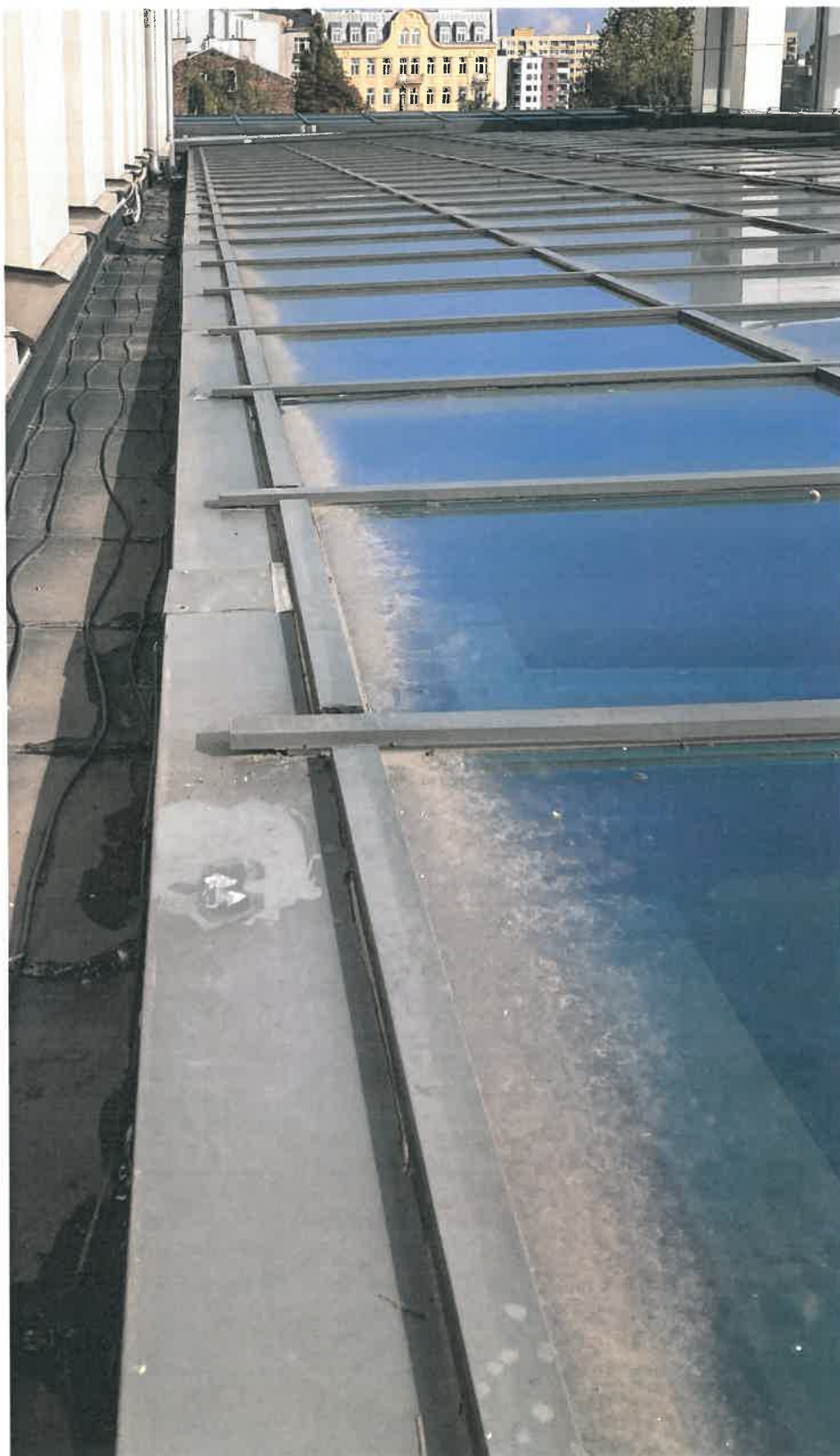
Fot. 25. Widok listew dociskowych rygli/płatwi blokujących odpływ wody opadowej, powodujących zaleganie zanieczyszczeń oraz przecieki cd
