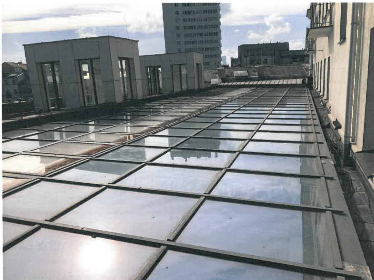
Fot. 2. Widok świetlika od zewnątrz od strony przeciwnej do tej z fot. 1 (widoczny pas okien oddymiających oraz rynna w osi B)
