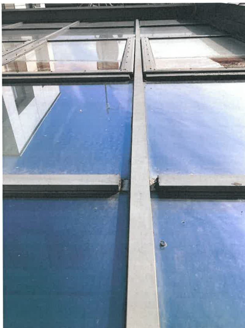
Fot. 35. Kłapy odymiające – zaleganie wody widoczne na szybach
