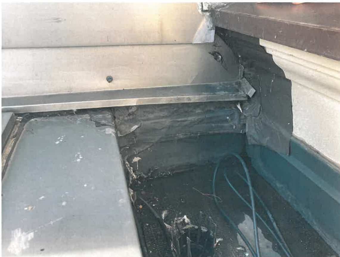
Fot. 39. Widok uszkodzonych obróbek – łatanie, lepienie, prowizorka; są to miejsca przecieków wody opadowej
