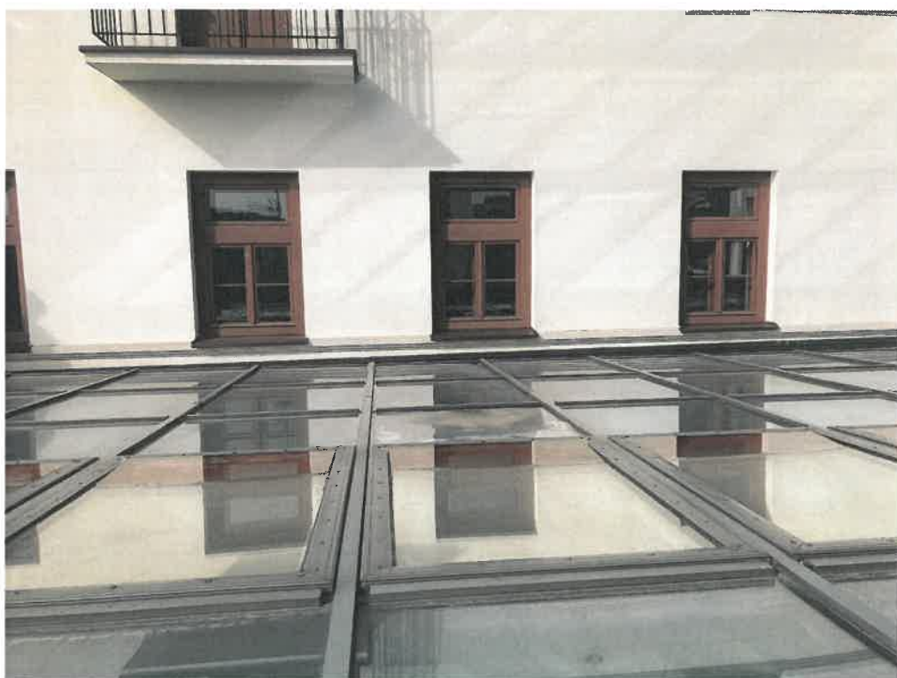
Fot. 34. Klapy odymiające – zaleganie wody widoczne na szybach, zaznaczone strzałką
