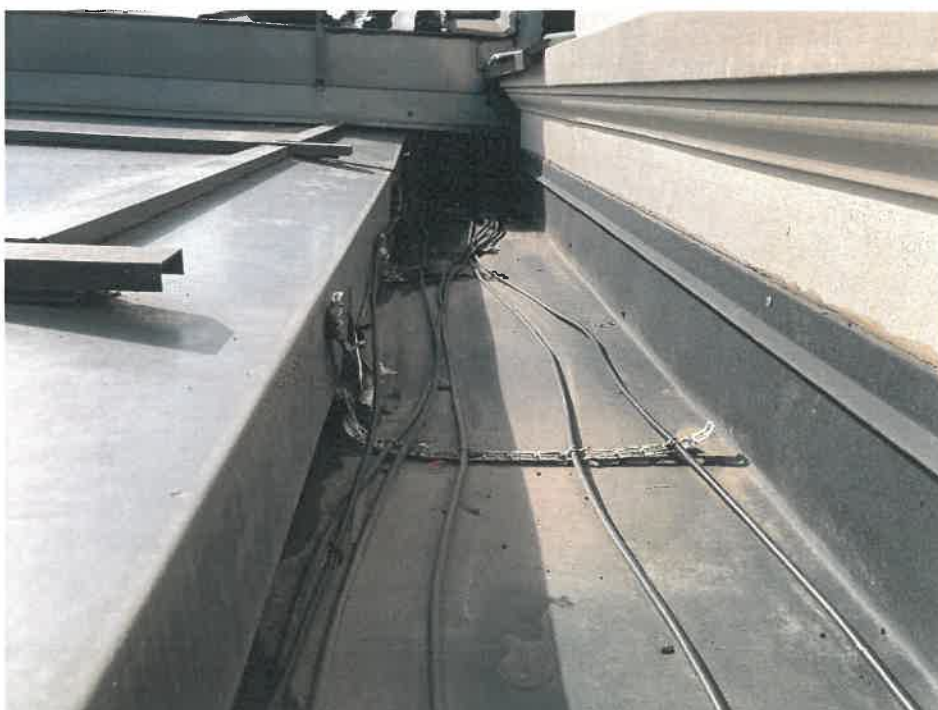
Fot. 40. Widok uszkodzonej obróbki rynny w osi B; miejsca przecieku wody opadowej
