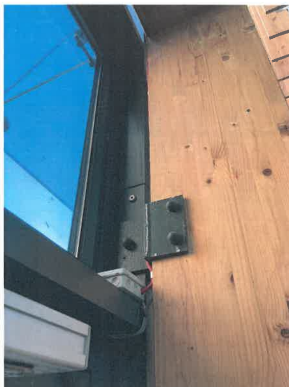
Fot. 6. Połączenie fasady ze ścianą
