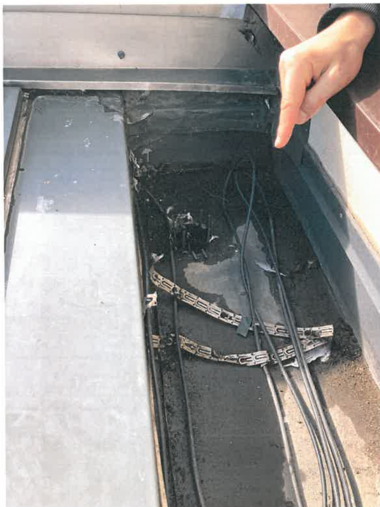
Fot. 38. Widok uszkodzeń rynny w osi B, spust trzeci z trzech
