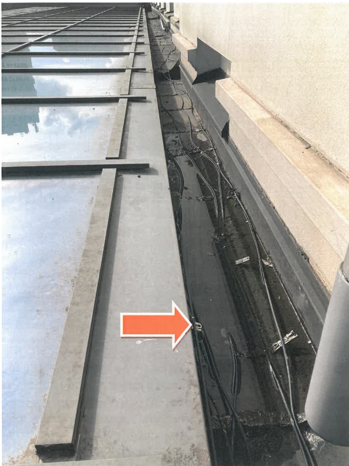
Fot. 16. Widok rynny w osi B – zaleganie wody w rynnie
