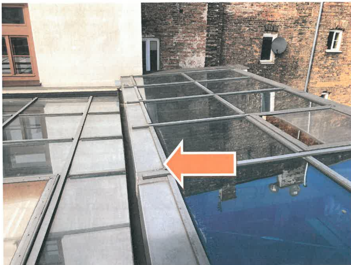
Fot. 15. Zrzut wody z części frontowej świetlika na poziomie +3 konstrukcja w osiach B-E / A10-A11 – rynna w osi 9
