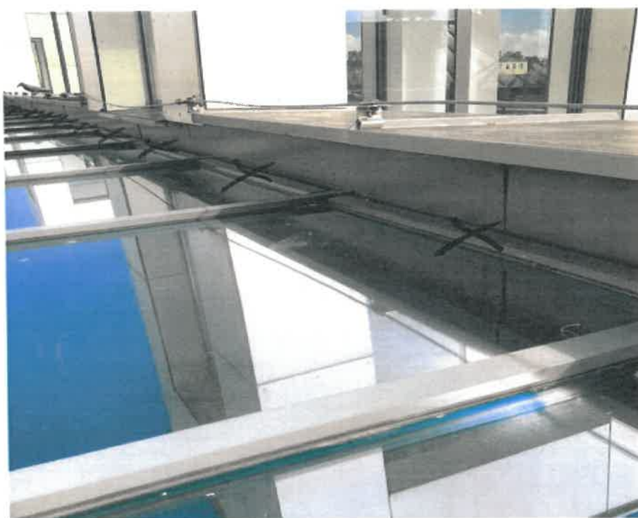
Fot. 27. Widok listew dociskowych płatwi oznaczonych literą x do zastąpienia płaskimi listwami z blachy nierdzewnej wg opisu w p. b) powyżej
