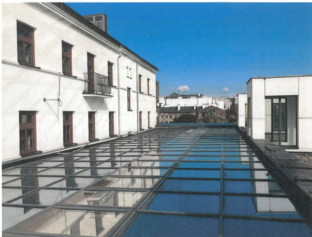
Fot. 1. Widok świetlika od zewnątrz (po lewej widoczne piętra 5 i 6 przyległego budynku, z którego dachu woda odprowadzana jest do rynny w osi B świetlika, widoczny również pas okien oddymiających)
