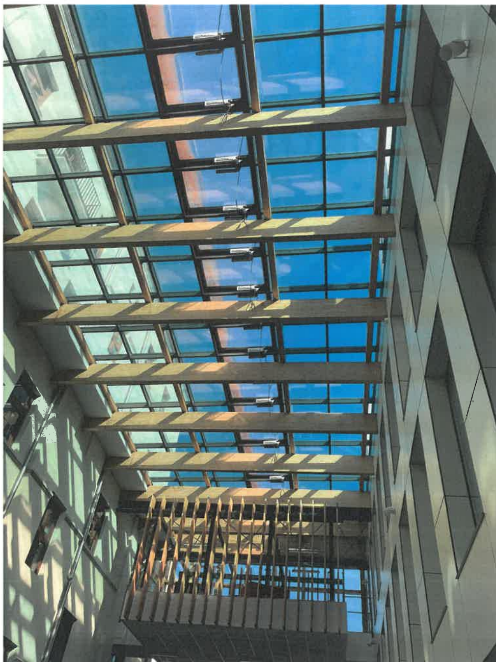
Fot. 3. Widok świetlika od wewnątrz w stronę strony wejścia głównego (widoczny pas okien oddymiających)
