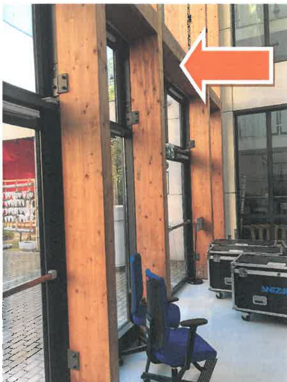
Fot. 5. Widok fasady strzałką oznaczono przykładowe zacieki
