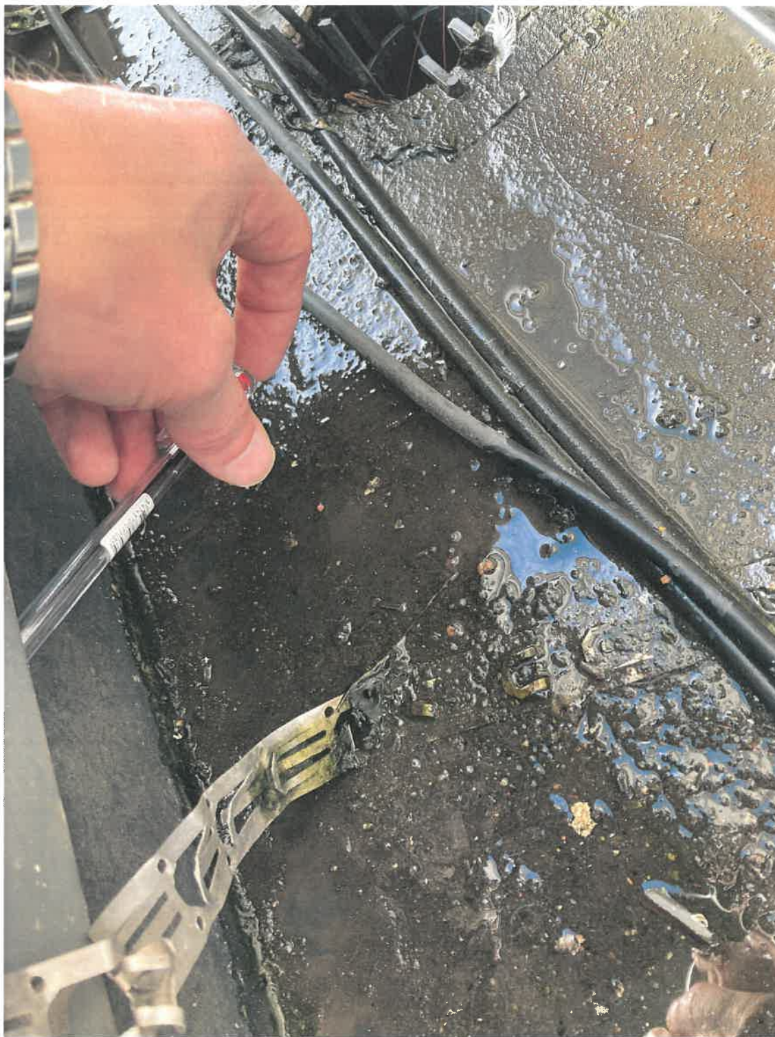
Fot. 37. Zalegający na konstrukcji i szybach brud i uszkodzenia kabli grzewczych w rynnie
