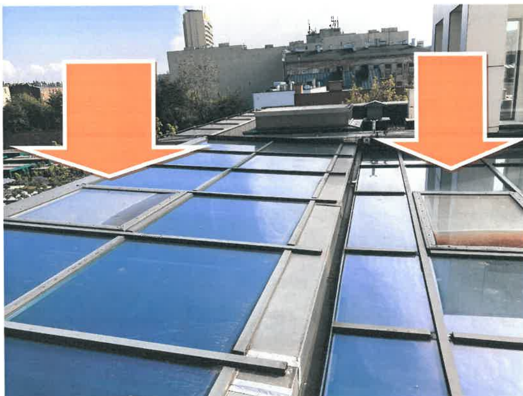
Fot. 31. Klapy odymiające – zaleganie wody widoczne na szybach, zaznaczone strzałką cd
