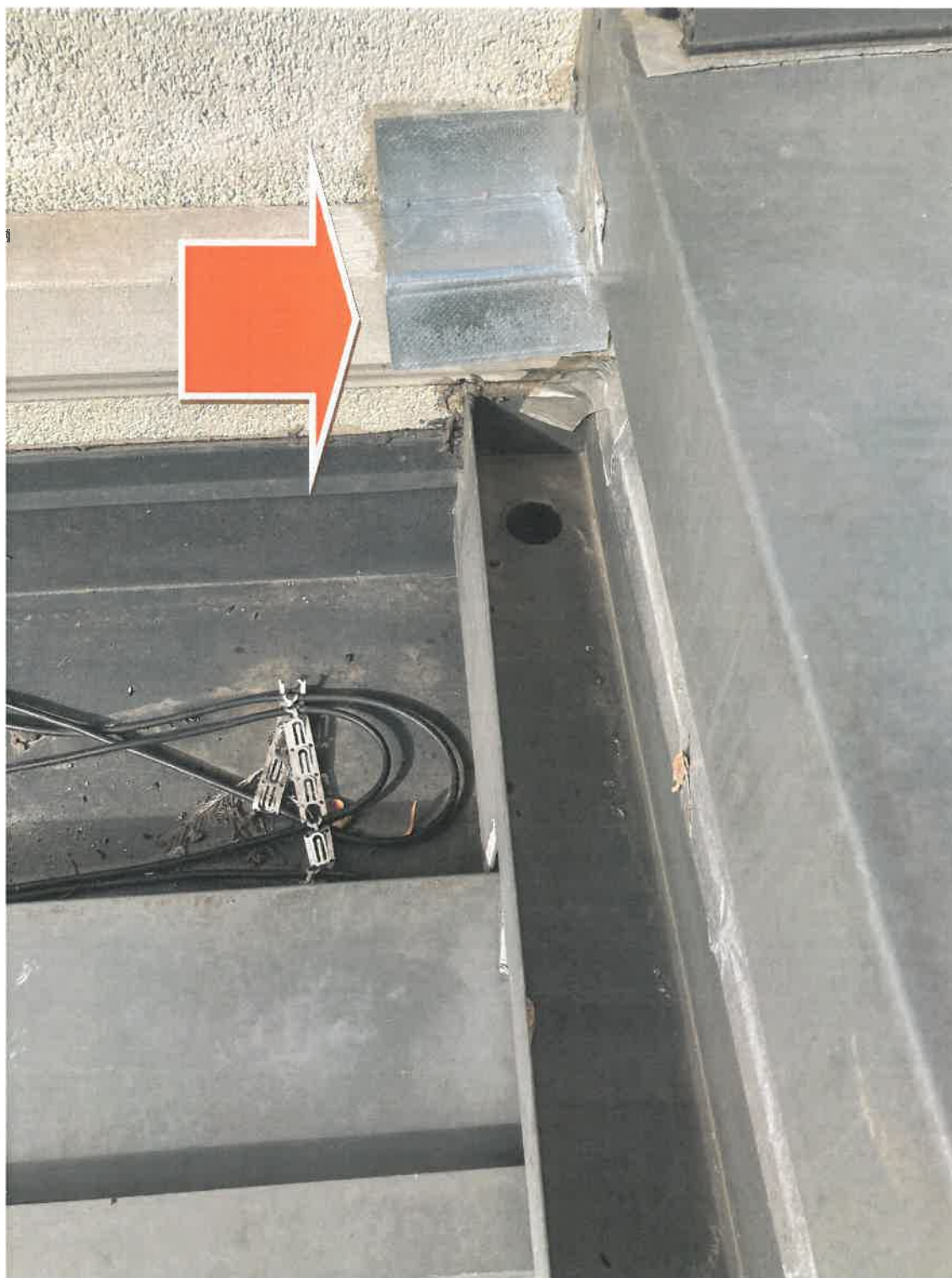
Fot. 42. Widok uszkodzonych obróbek – łatanie, lepienie, prowizorka; są to miejsca przecieków wody opadowej - rynna w osi 9
