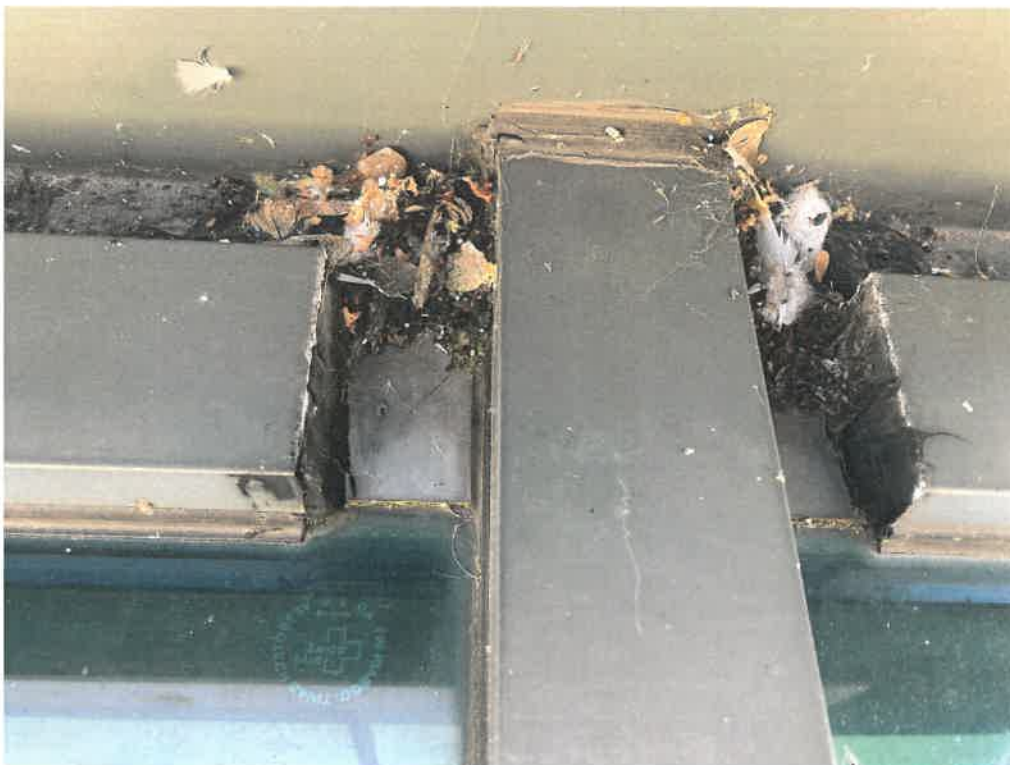
Fot. 26. Widok listew dociskowych rygli/płatwi blokujących odpływ wody opadowej, powodujących zaleganie zanieczyszczeń oraz przecieki cd
